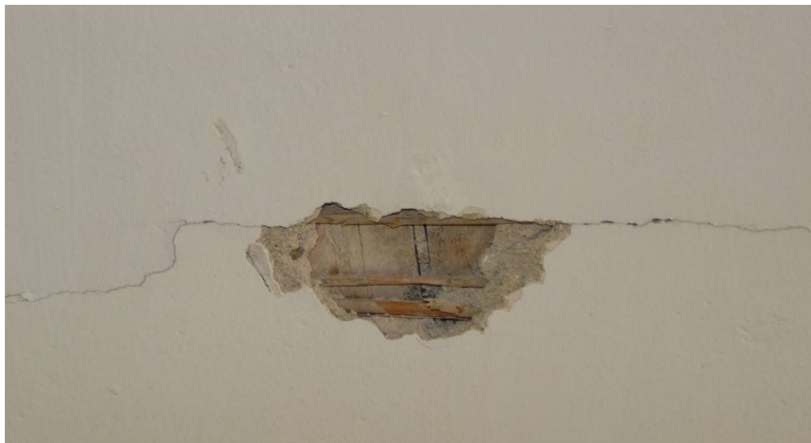
Tynk na trzcinie stropu drewnianego
