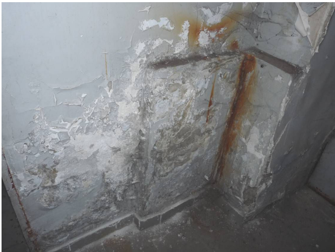
Wykwity solne ścian i zawilgocenie ścian piwnic
