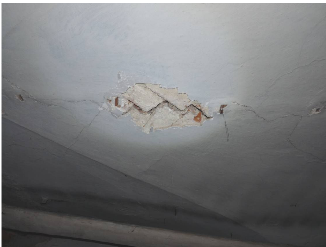
Pęknięcia sklepienia ceglanego stropu nad piwnicą w budynku nr 8
