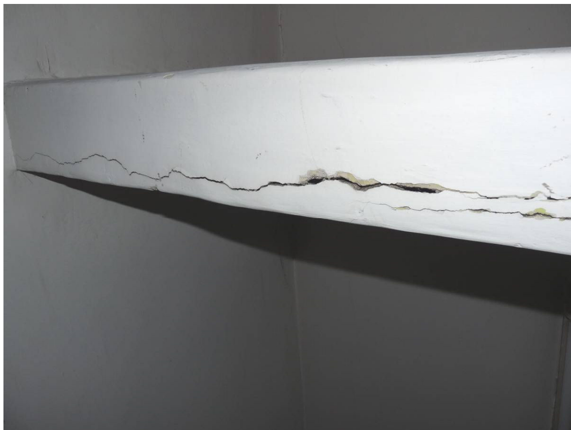
Spękania konstrukcyjne podciagu żelbetowego
