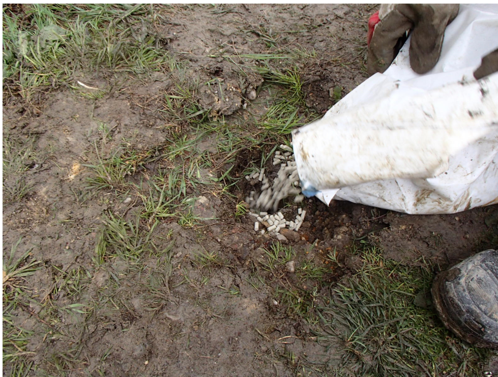
Fot. 24. Likwidacja otworu mieszanką grunto-bentonitową z korkiem bentonitowym zapobiegającym penetracji głębszych warstw osuwiska przez wody opadowe.
