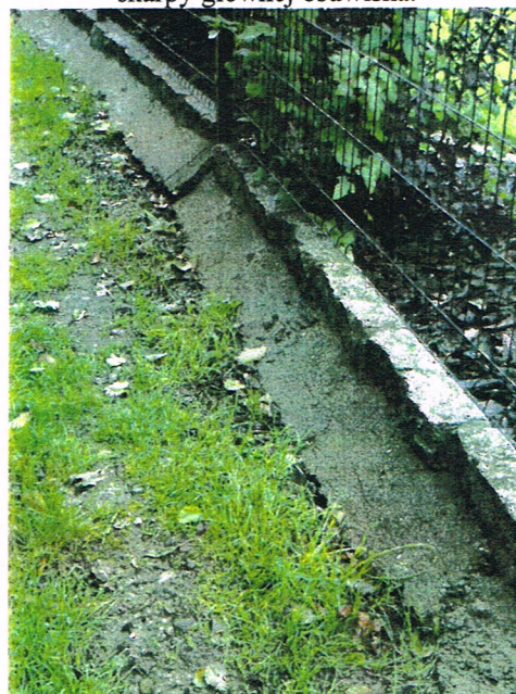
Przesunięcie ogrodzenia posesji na zachodnim odcinku skarpy głównej osuwiska.
