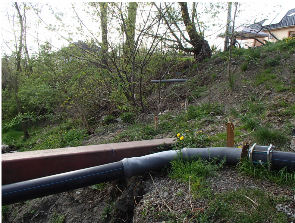
Fot. 3. Nisza osuwiska (punkt 3N), z widoczną rurą odprowadzającą deszczówkę z położonego w bliskim sąsiedztwie budynku gospodarczo – mieszkalnego.
