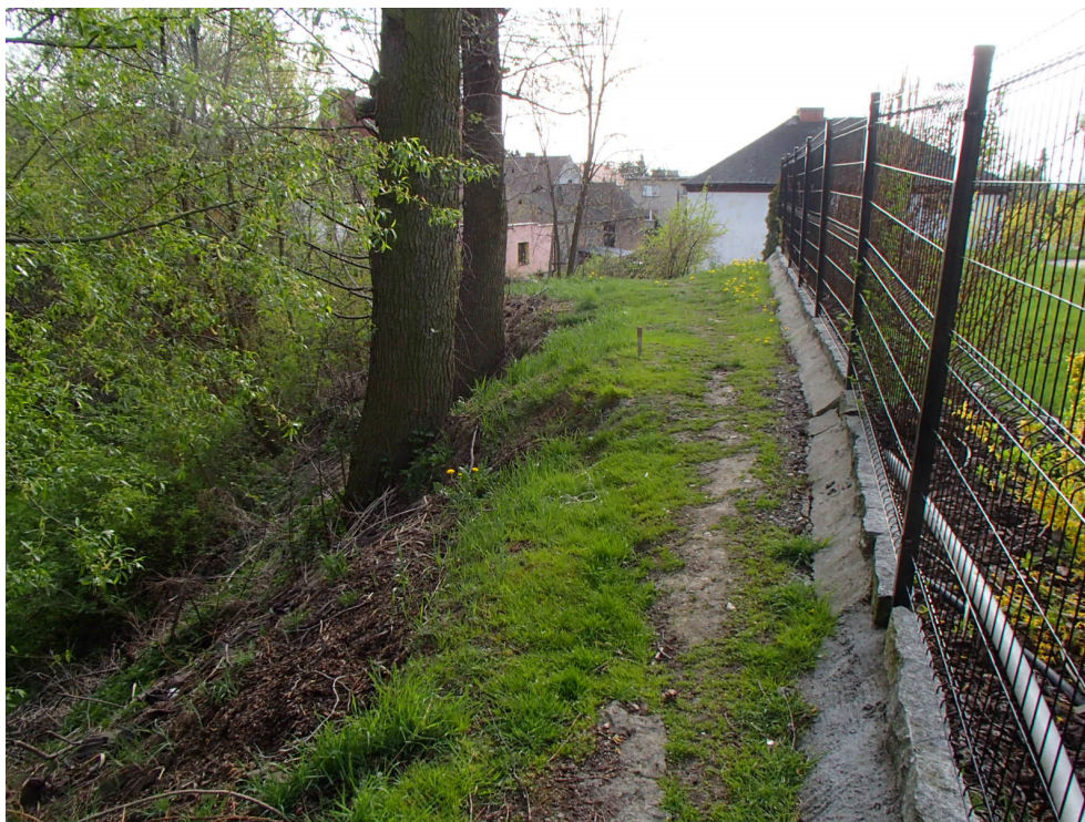
Fot. 11. Widok na punkt 4N, (zlokalizowany poza strefą odkłucia – zachodnia część osuwiska). Po prawej stronie widoczne uszkodzone od ruchów masowych ogrodzenie.
