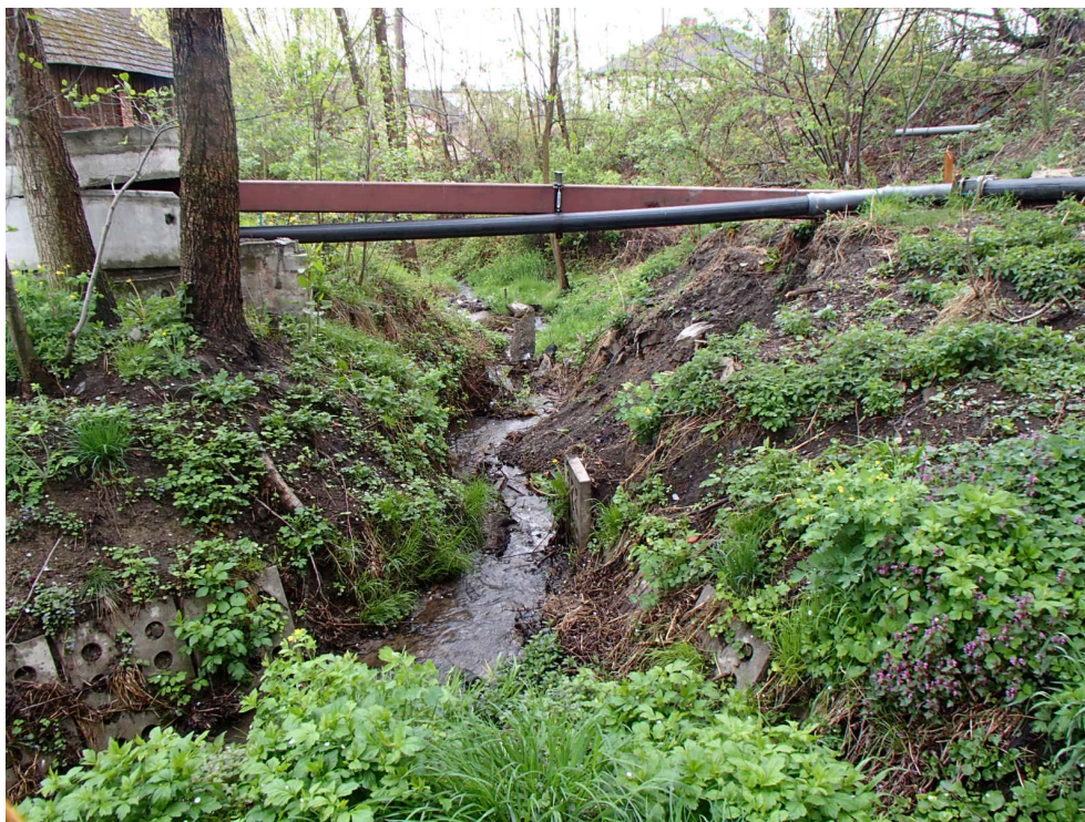
Fot. 5. Prawa strona rowu- czoło osuwiska i koluwium zasypujące koryto cieku
