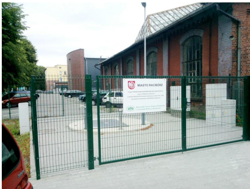
Fotografia 2. Widok na przepompownię wód deszczowych przy ul. Piaskowej. (fot. UM)
